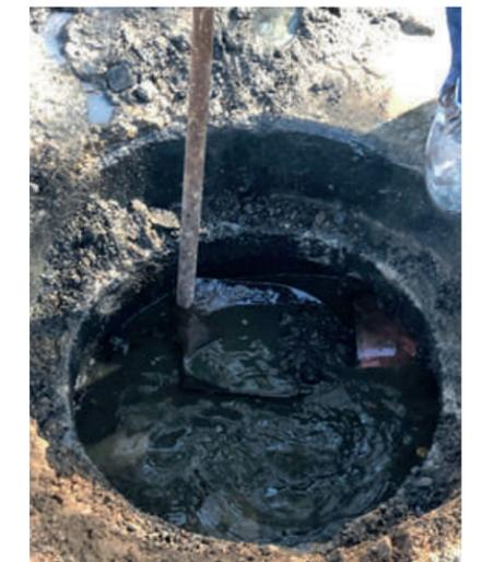
**4.-DESASOLVE DE 35 METROS LINEALES RED DE AGUA POTABLE EN FRACC. LAS NUBES Y LAS BRISAS**
